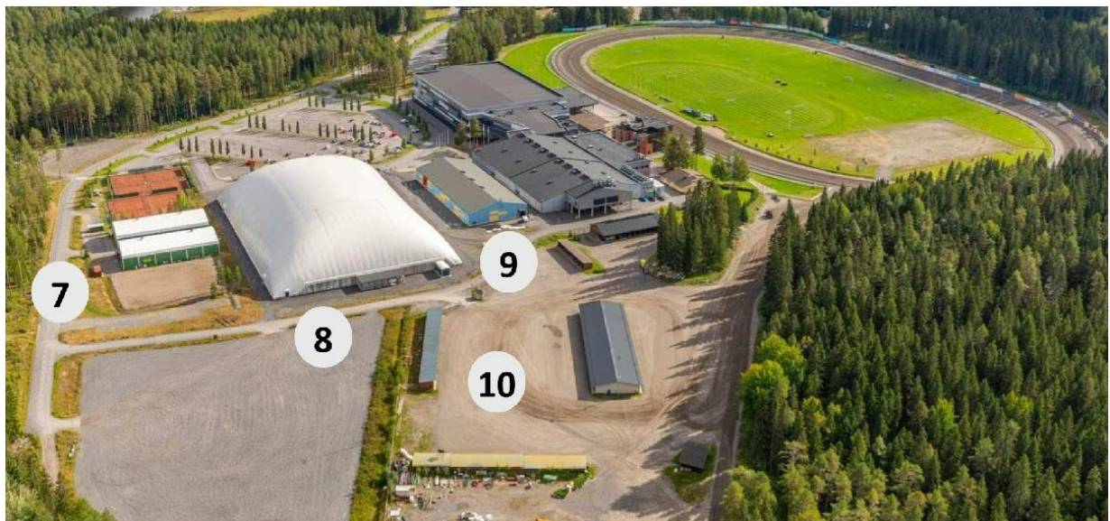
Kuva 4 Sunnittelualueen rakennuksia kuvattuna pohjoisesta.
